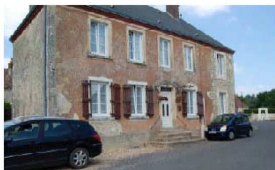
La Maison de bourg est à RDC +1 + C. Sa toiture est à croupes, les murs sont en moellons de calcaire enduits.
