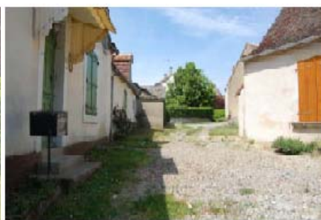
La cour de la Classe et le passage des Dentellières sont deux secteurs particulièrement intéressants du point de vue de l'organisation et de la volumétrie des bâtiments. Toutefois une mise en valeur du site est nécessaire.
