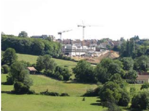
Vue sur l'hôpital de Bellême en cours de construction depuis le golf.
