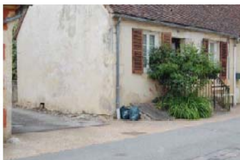
Maison ouvrière : R+C, plan rectangulaire, volume compact, moellons enduits, toit à deux versants en tuiles plates.
