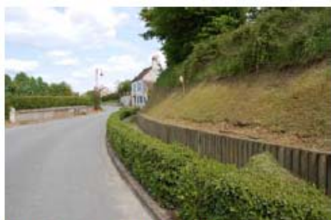
La traversée du bourg par la RD 274 a été sécurisée par un petit sentier piéton.
