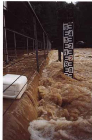
Le Moulin de Bouchot – crue de mai 2000
