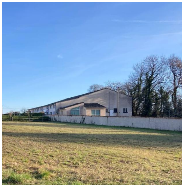
Parc arboré et entreprise au sud du site
