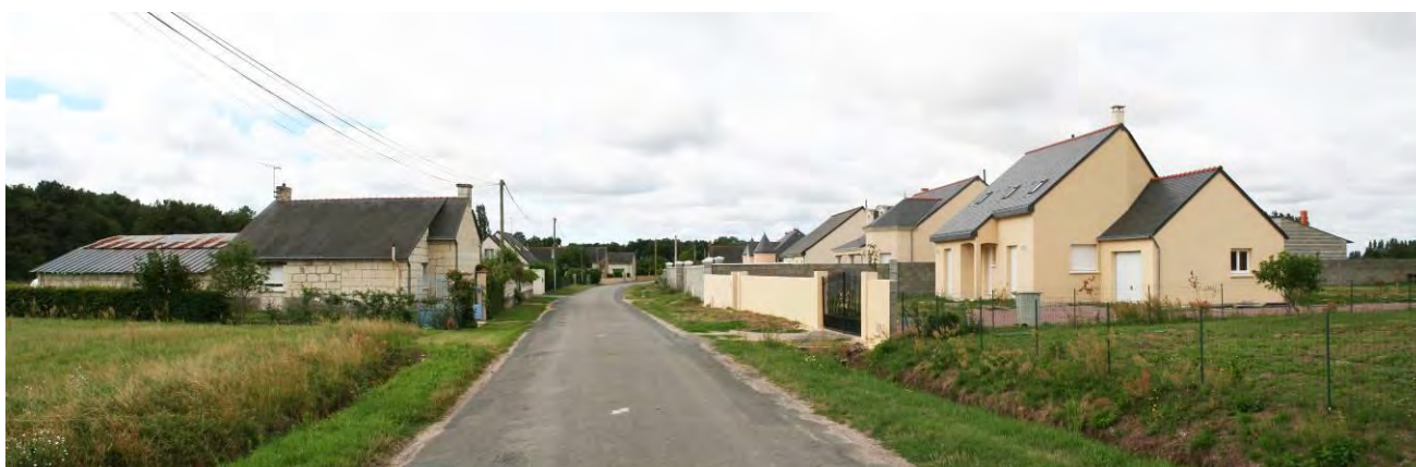
Urbanisation linéaire le long des routes à Vivy
