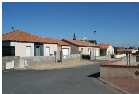
Couverture en tuile des nouvelles constructions (Antoigné)
