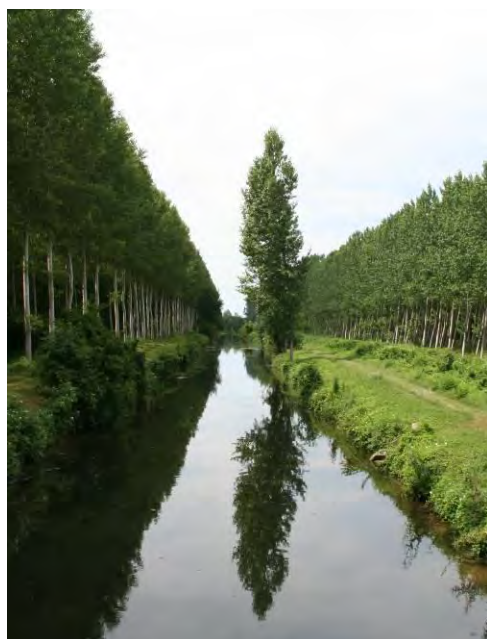
Epieds Alignements de peupliers le long du canal de la Dive
