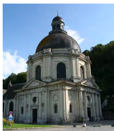
Eglise Notre-Dame des Ardilliers Classée - Saumur
