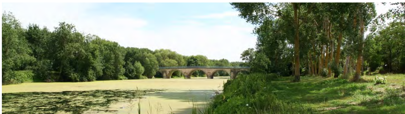
Pont traversant la Thouet à Saint-Just-sur-Dive
