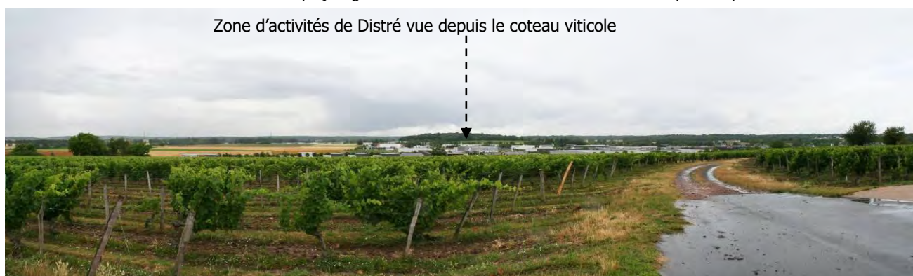
Création d'un paysage industriel aux abords de la RD 347 (Distré)
