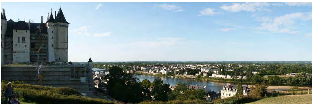
Vue remarquable sur Saumur et la vallée ligérienne depuis le château
