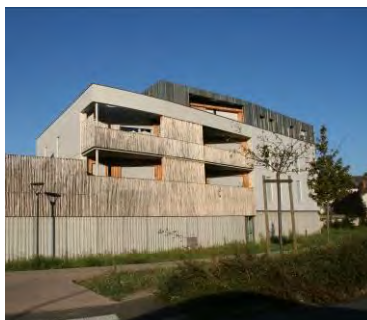
Habitat collectif à Saumur utilisant le bois et le PVC
