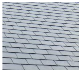
Toiture en ardoise plate
