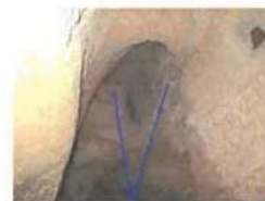
Zone de remblai, instable, sans cohésion. Stabilisation par élévation de maçonneries
