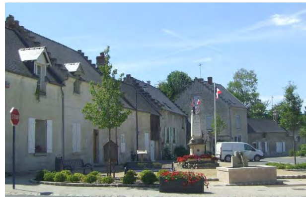
Maisons avec rive de pignon en pas de moineaux – Ressons-le-Long
