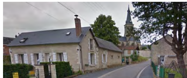
Maison de village, pignon sur rue, annexe en L – Vassens
