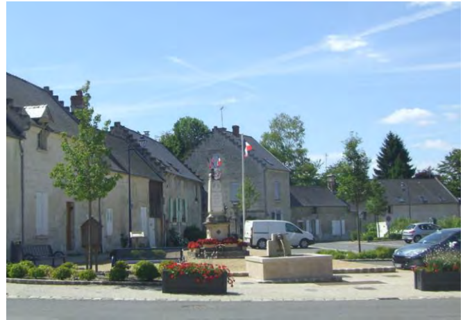
Espace de pause – Traitement Minéral – Ressons-le- Long – Source : Altereo
