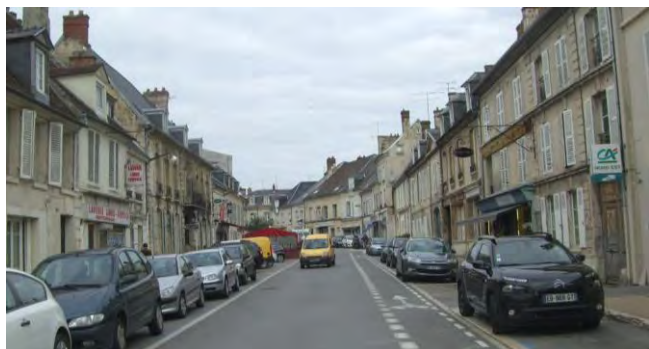
Maisons de ville de type R+1 à R+2+combles - Villers-Cotterêts
