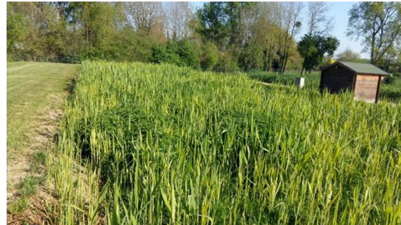
Photo 23 Station à Anaïs, avec filtres à roseau, capacité 350 EH
