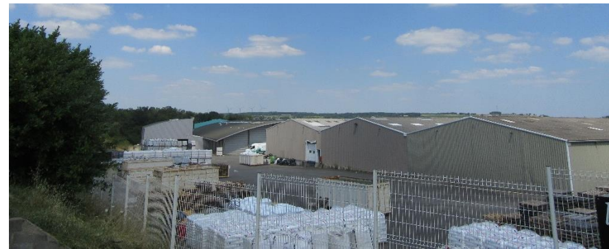
Photographie : Structures métalliques en zone d'activité
