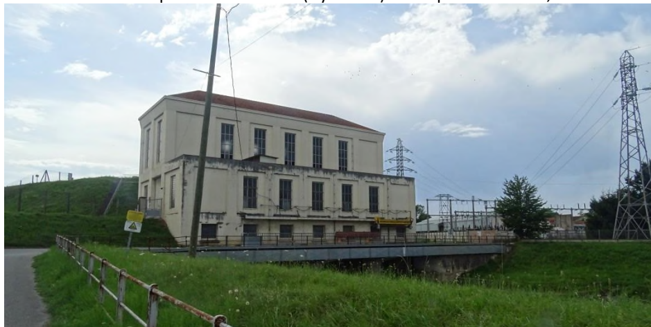
Photo 8 : Centrale hydroélectrique de Valentine – Source : EVEN Conseil
