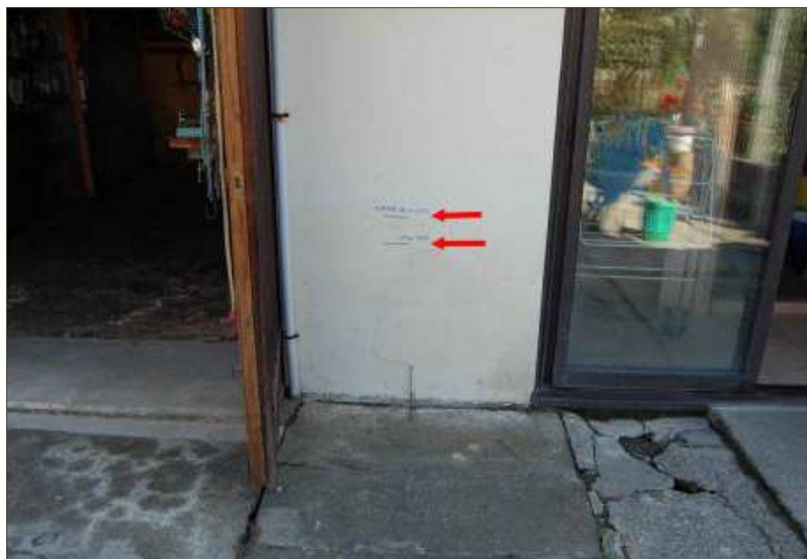
Photo n° 1 : Commune d'Ausson, n°1 rue de l'Eglise. Les repères des crues dans la cour intérieure : crue de 1977 (0.65 m au-dessus du terrain naturel) et crue de 2013 (0.75 m au-dessus du terrain naturel).
