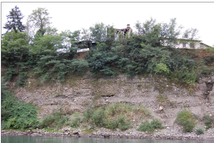
Figure n° 20 : commune de Pointis-de-Rivière, sous le bourg de Pointis-de-Rivière Lors de la crue du 18 juin 2013, il y a eu un effondrement du talus.
