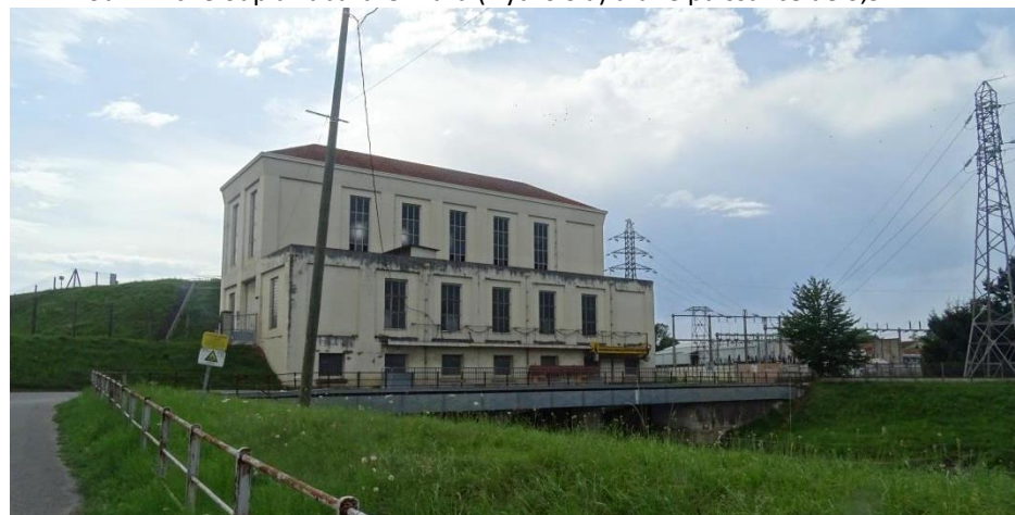
Photo 8 : Centrale hydroélectrique de Valentine – Source : EVEN Conseil
