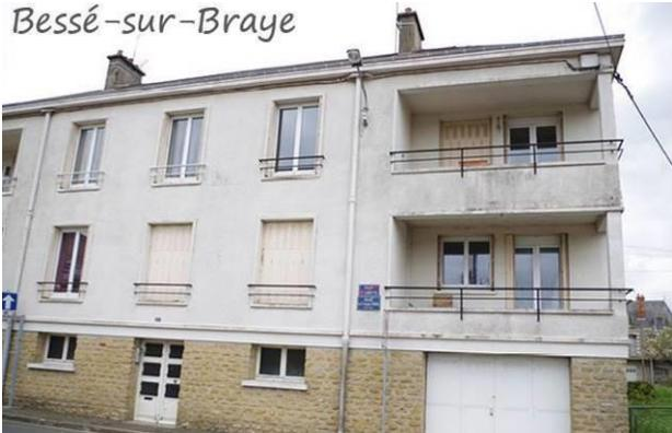
Collectif R+2 à Poix-de-Picardie de style 1950. Traitement qualitatif en pierre naturelle en rez-de-chaussée. Utilisation du béton et du fer de profil tubulaire caractéristique de l'époque.
