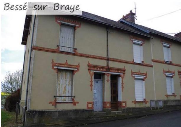
Maison ouvrière R+1+C avec modénatures de briques recherchées. Travail sur la topographie avec groupement par deux des maisons sur un même niveau.
