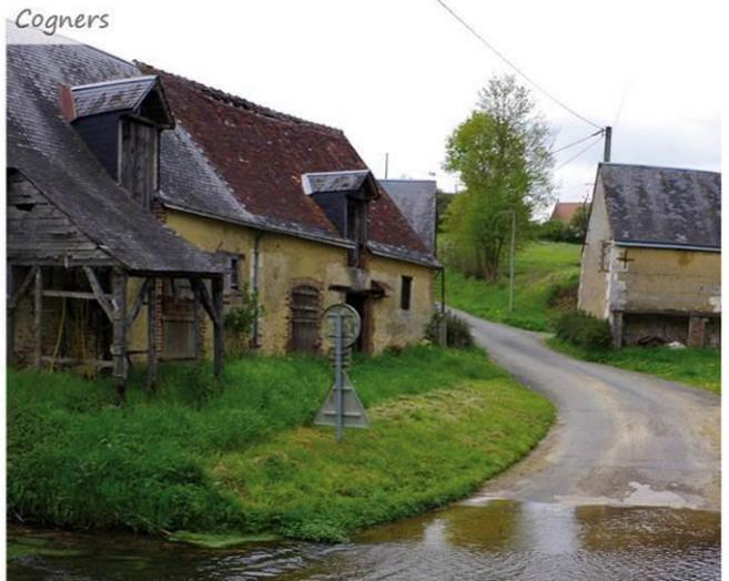
Lucarnes meunières. Encadrement de baies en brique flammée. Chaînage d'angle en pierre de taille de tuffeau. Couverture en tuile plate et ardoise
