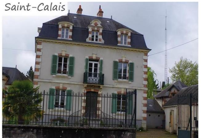
Maison bourgeoise au centre d'un jardin d'apparat. Façade équilibrée. Toit à la Mansart en ardoise. Bâti à plan carré. Baies plus hautes que larges. Encadrement des baies et chaînage d'angle avec alternance de pierre calcaire et de briques. Mur bahut surmonté d'une grille en ferronnerie d'art.
