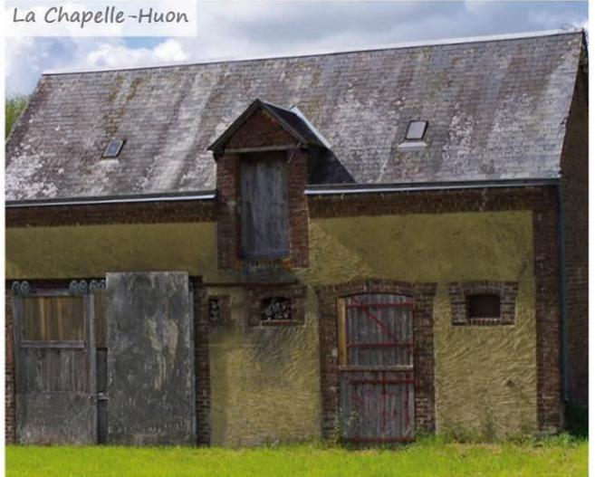
Grange avec couverture en ardoise. Lucarne meunière. Encadrement des baies et arêtes avec la brique flammée. Enduit au mortier de chaux donnant une lumière particulière à la construction
