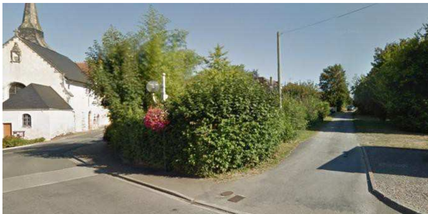
Chemin de la Forge (entrée de l'opération)
