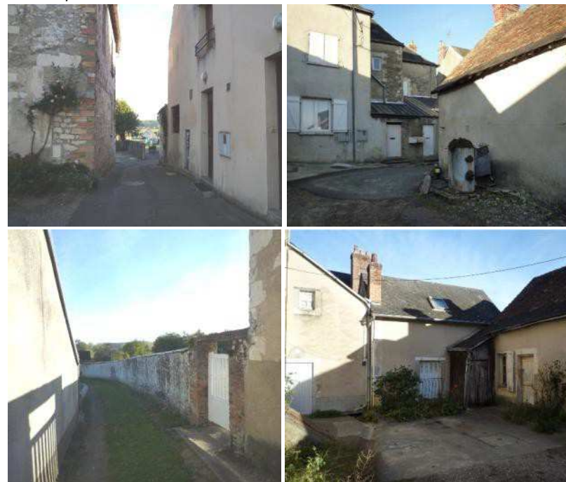
Le site est irrigué depuis la rue Principale via un réseau de venelles étroites, sinueuses et complexes, imbriquées dans le bâti qui s'organise sous forme de courées. Le registre des murs et des jardins est omniprésent sur le secteur.
