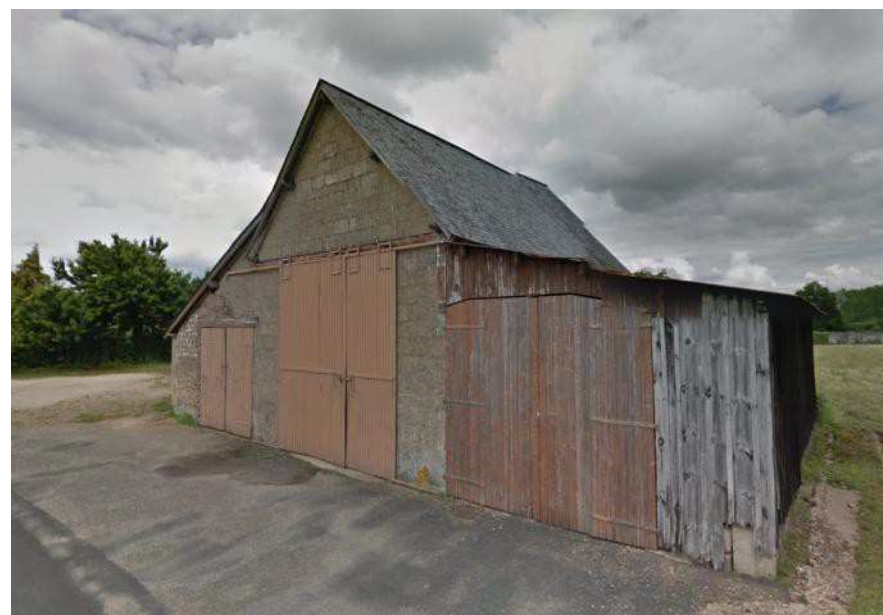
Bâtiment existant donnant sur la rue des Voltigeurs
