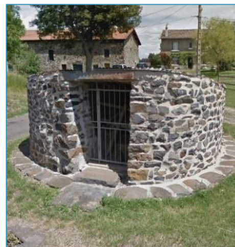
Puits fermé - Le Monastier-sur-Gazeille (village du Mont)
