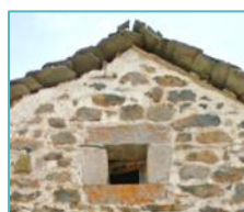
Ouvertures avec encadrement en pierres de taille
