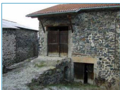
Aspect traditionnel d'une montade sur une grange - Lantriac
