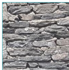
Mur en pierres granitiques
