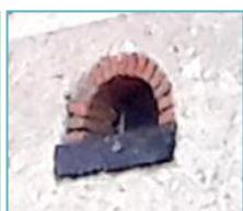
Ouvertures avec encadrement en briques
