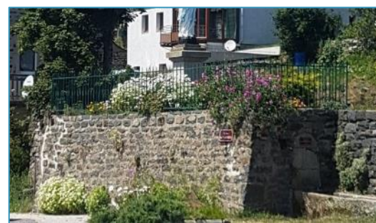
Mur de soutènement - Les Estables
