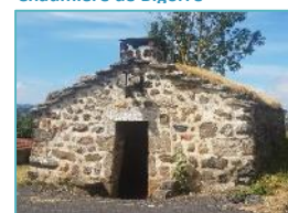
Four à Pain Source : Campus Développement
