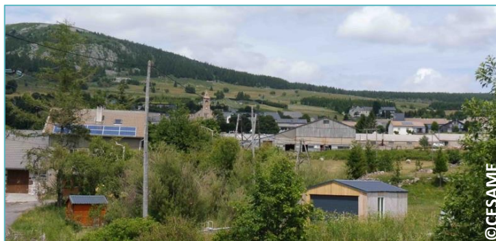
Installations solaires sur des maisons aux Estables
