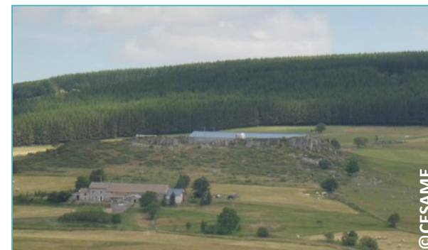
Installations solaires sur un bâtiment agricole sur les pentes du Rocher Tourte (Freycenet-la-Cuche)
