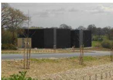
Bâtiment existant sur la ZA des Pavés
