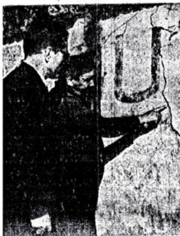
M. Péan, de Limons, montre à M. Dessens une fissure de plusieurs millimètres.
