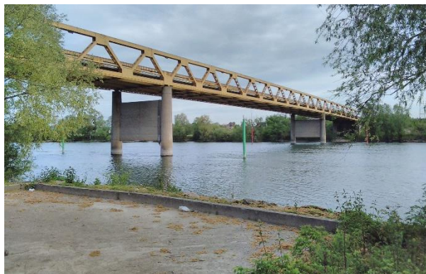
Figure 53 : le pont Aubevoye-Courcelles
