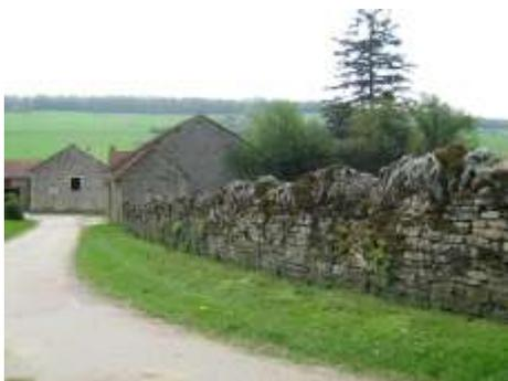
**Prescription :** Conservation en l'état. Les végétaux se développent entre les pierres et les désolidarisent, contribuant à la dégradation des murets. Quelques travaux et un entretien courant permettraient de les préserver.
