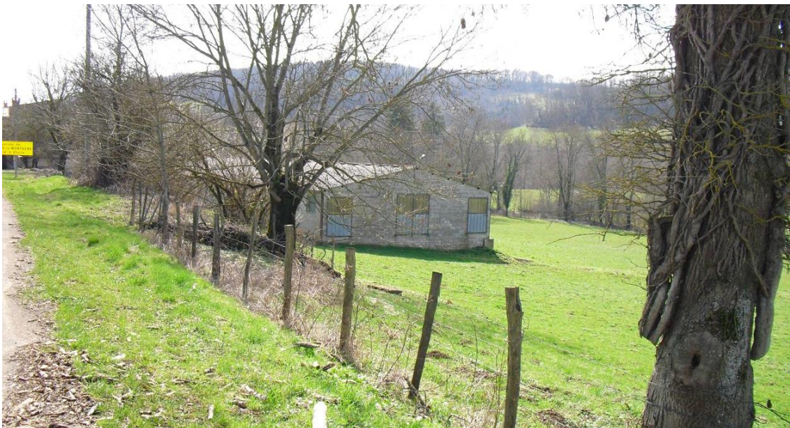
Les boisements à droite masquent partiellement le bâtiment agricole.
