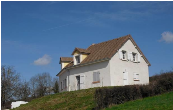
Construction récente implantée en hauteur avec terrassements
