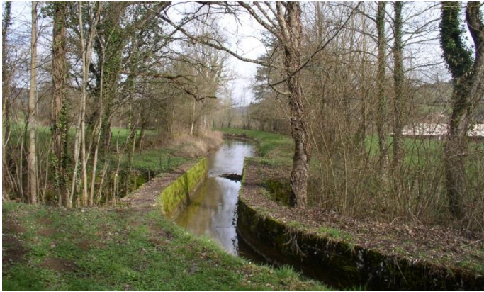
Rigole d'alimentation du canal de Bourgogne
