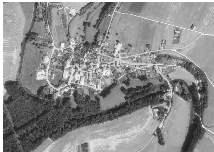
Photographie 20 : Vue aérienne de 1978
