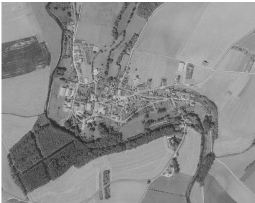
Photographie 21 : Photographie aérienne de 1988
