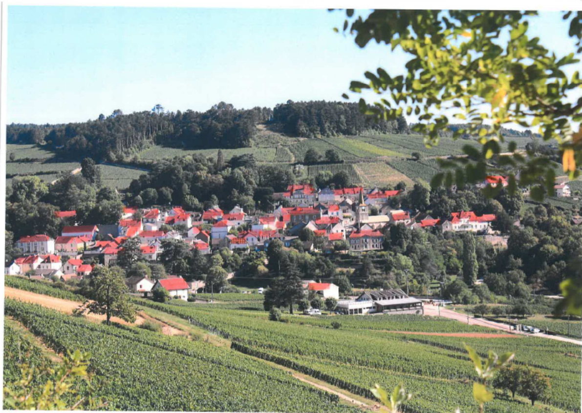
Localisation (en rouge) des toitures présentant une sensibilité paysagère et monumentale. ***
