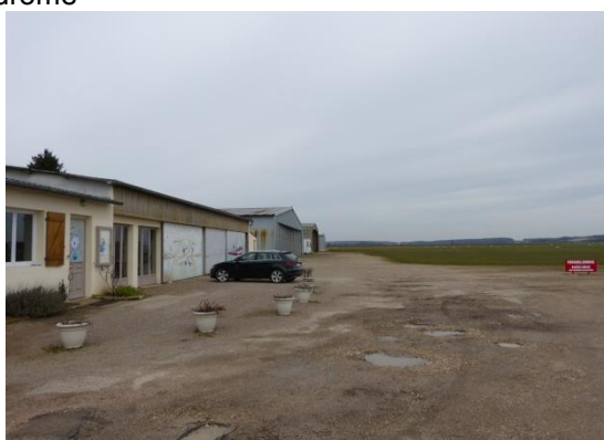
- les locaux de l'ancienne gare (avec des logements)
