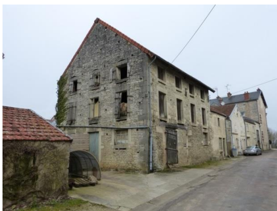
D'anciennes habitations sont utilisées pour le stockage de matériel agricole
