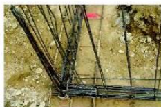
Nœud de chaînage - Continuité mécanique
