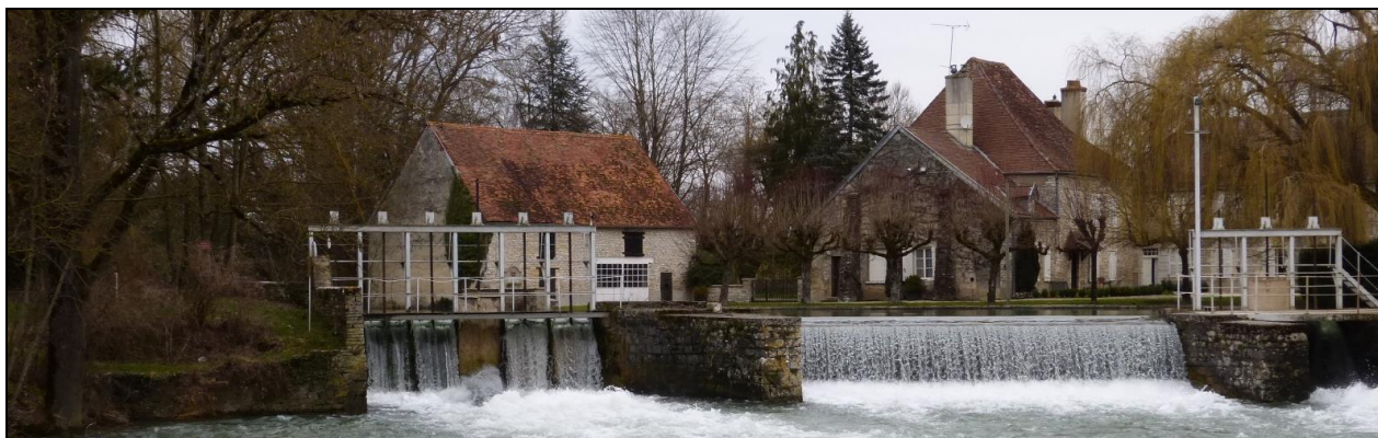
Seuil en amont immédiat du moulin.
