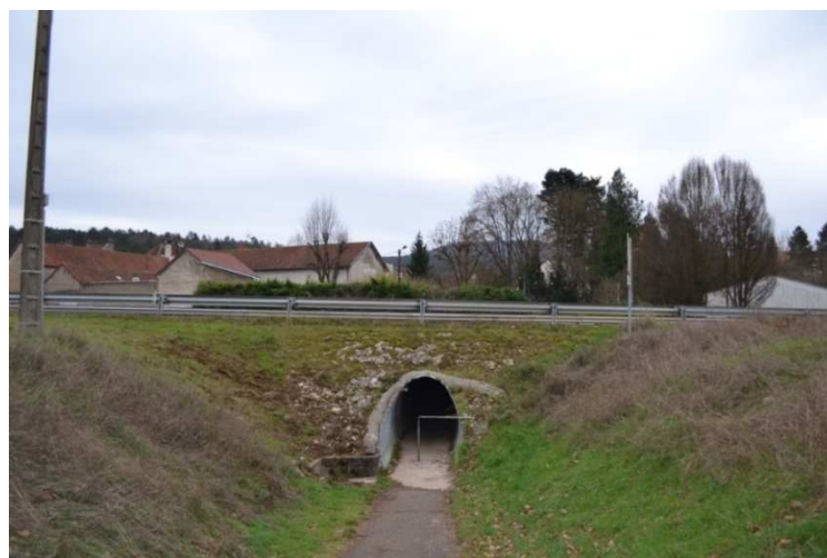
Figure 13 : Tunnel piéton (Réalisation : DORGAT)
