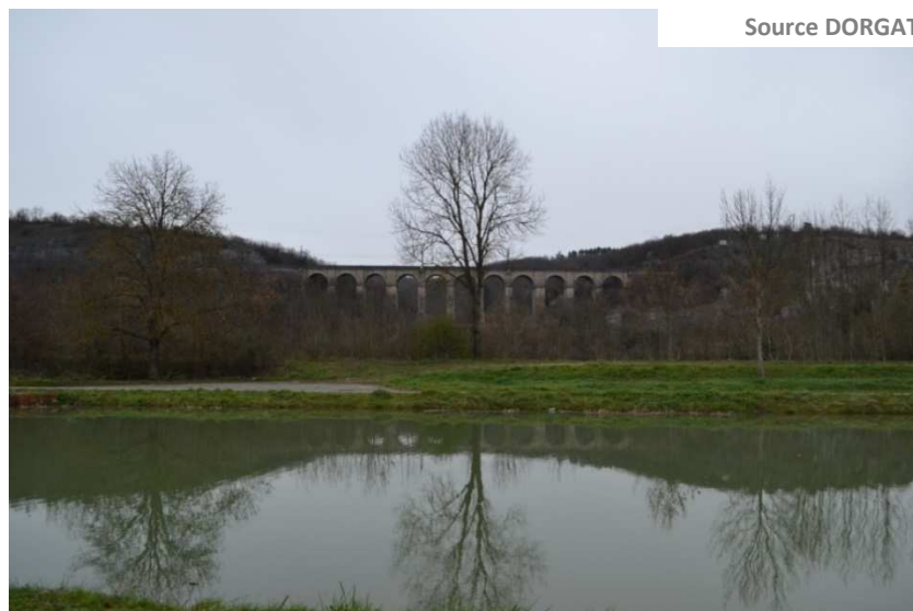
Figure 5 : Vue sur le viaduc de la Combe de Fain
