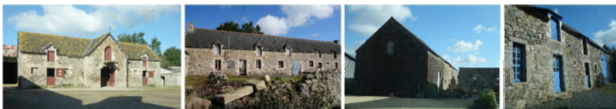
Exemple de bâtiments concernés au Champ Chapel, Saint-Laurent, La Ville Jouan et La Ville Coquette
