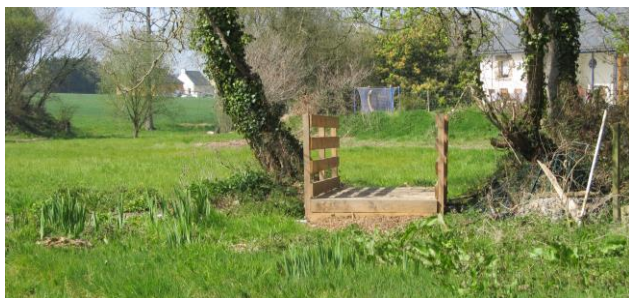
Promenade piétonne en cours d'aménagement dans le vallon du DOURDU
