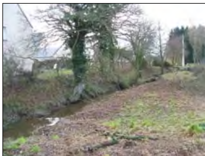
Débroussaillage et mise à nu de la ripisylve sur un affluent du Gast à Trégomar.
