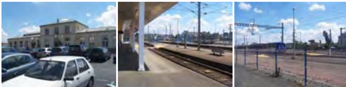
Différentes vues de la gare SNCF de Lamballe
