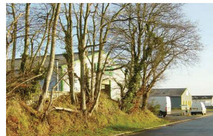
Vue depuis la voie de desserte
