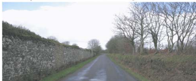
Mur de pierre à Komanant Kammig
