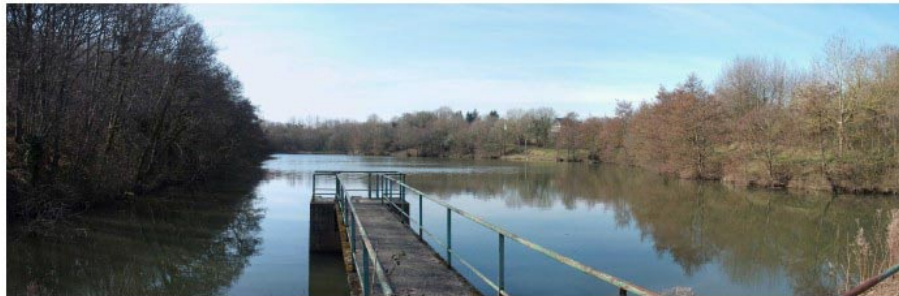
Barrage de Montafilan
