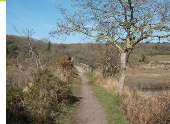
Structures anciennes, permettant le cheminement
