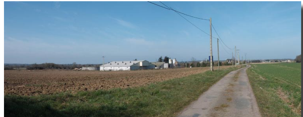
△ Le plateau Sud, ponctué de bâtiments agricoles
