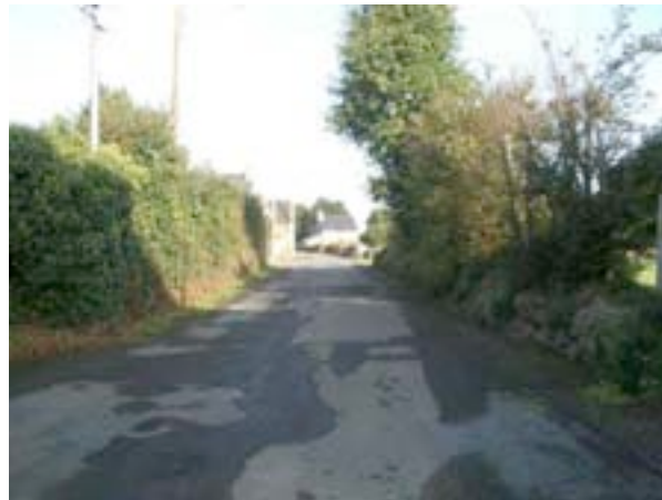
Rue du Clos de Pierre Murs, Talus
