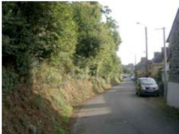
Rue du Stade Mur et Talus arboré.
