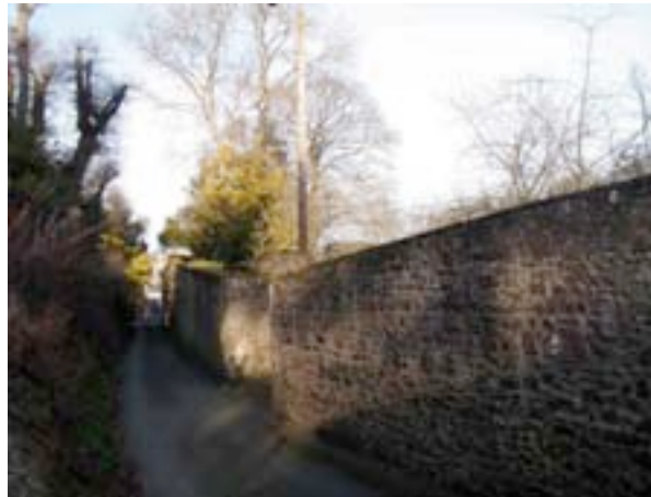
Rue du Four à chaux Mur
