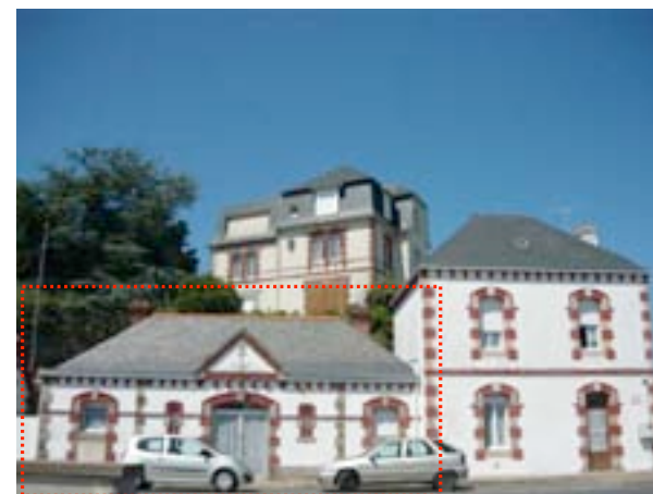
6 Quai de la République Bureau du port
