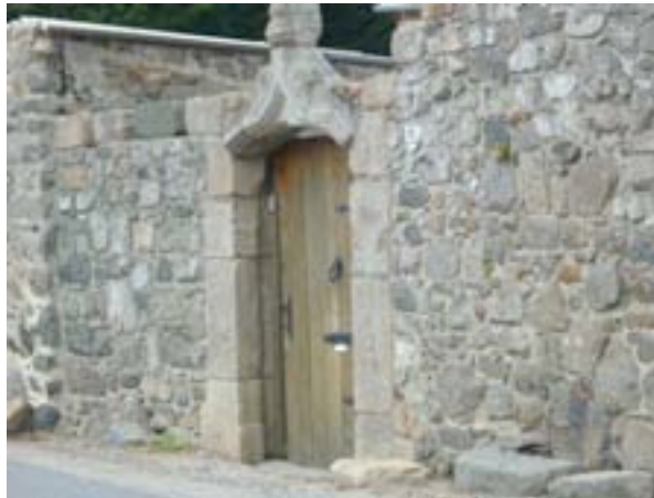
15, rue des Besaces, Clôture
