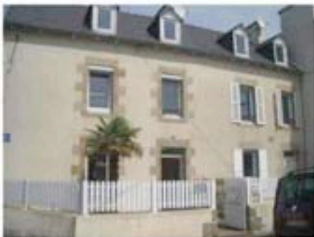
Bâti de centre ville
