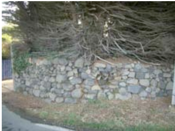
Rue du Stade Mur et Talus arboré.
