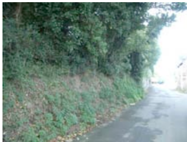
Rue des Dolmens Murs et Talus
