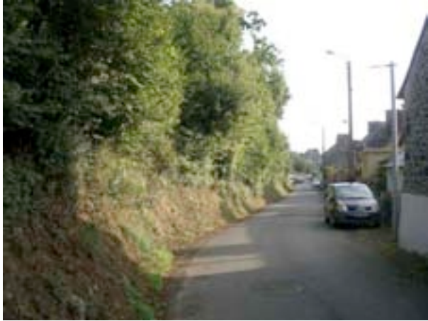
Rue du Stade Mur et Talus arboré.
