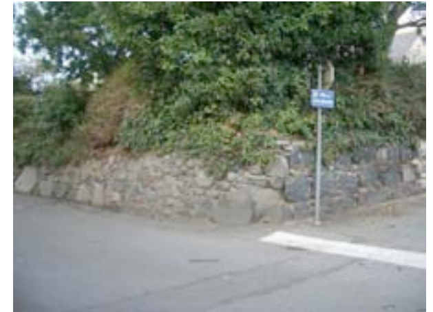
Rue des Dolmens Murs et Talus
