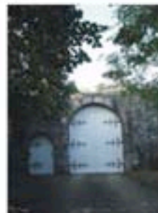
Le Portail maçonné du Manoir du Tertre du Gac
