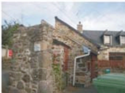
Association de schistes, granites en parement et ardoises en couverture
