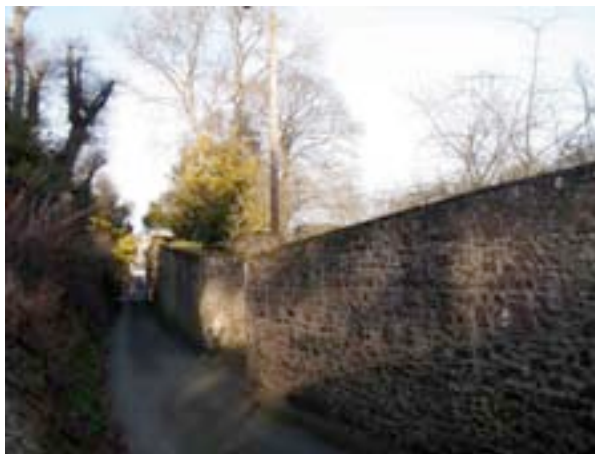
Rue du Four à chaux Mur
