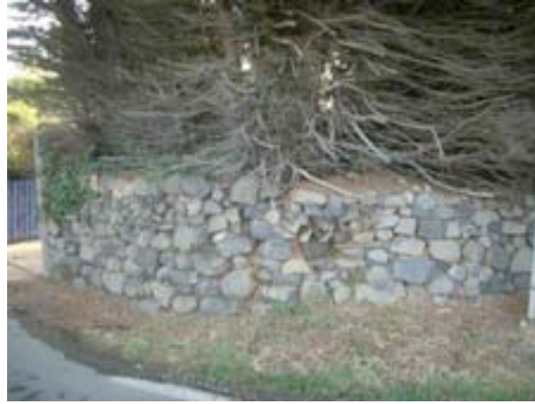
Rue du Stade Mur et Talus arboré.
