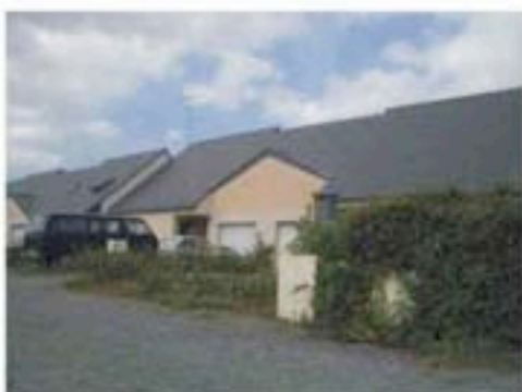
Opération neuve à l'aspect précaire
