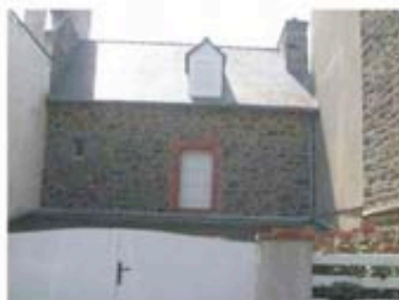
Maison de pierre encastrée en retrait
