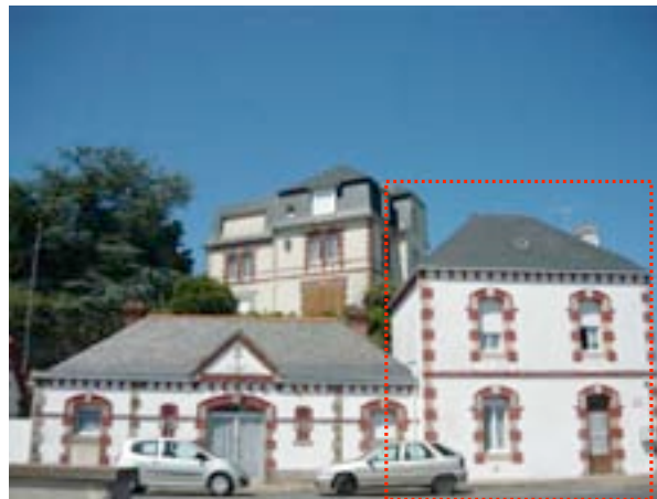
4 Quai de la République Logement du gardien du phare
