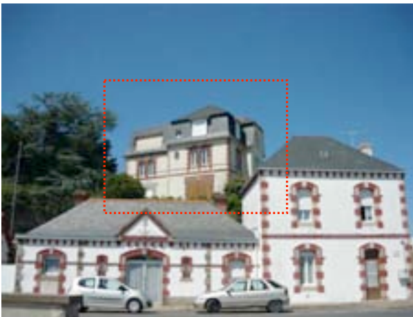
2 quai de la République Maison du Maître de port
