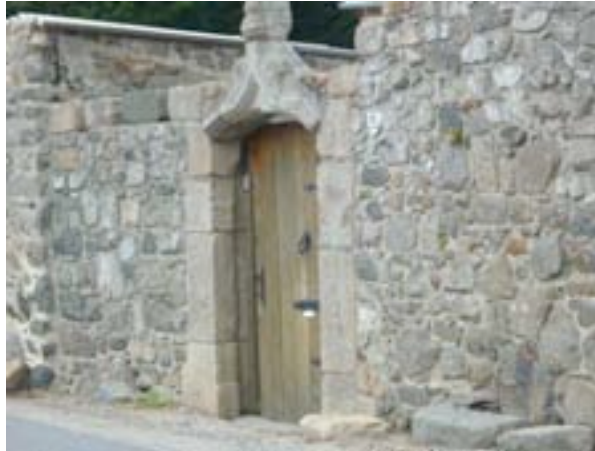
15, rue des Besaces, Clôture
