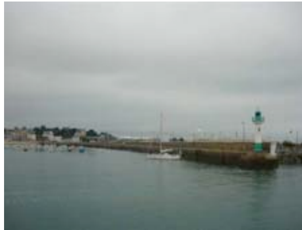
Quai et parapet
