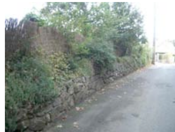
Rue des Dolmens Murs et Talus
