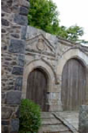
5, rue de l'Yser Mur et Portail
