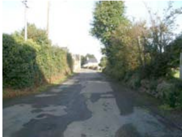
Rue du Clos de Pierre Murs, Talus
