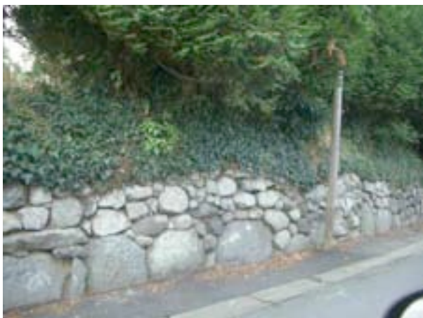
Rue des Dolmens Murs et Talus
