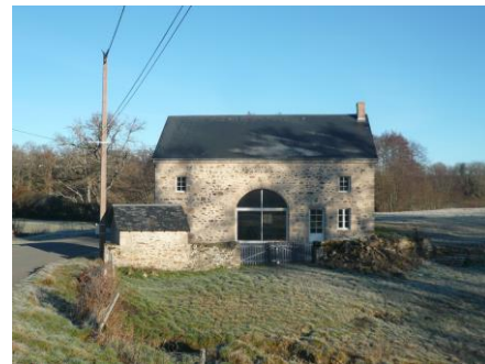
Habitation en cours d'aménagement en gîte à Bâtisse
