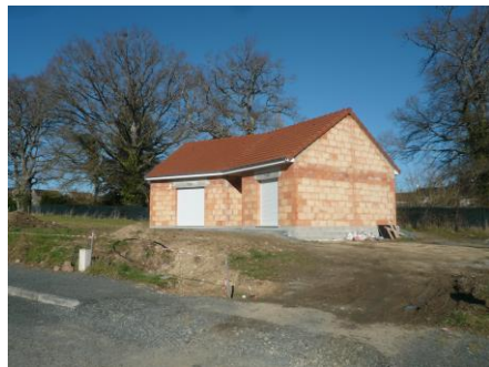
Construction en cours d'une habitation (février 2022) dans le bourg
