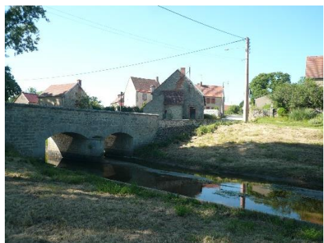
Forges : pont et lavoir
