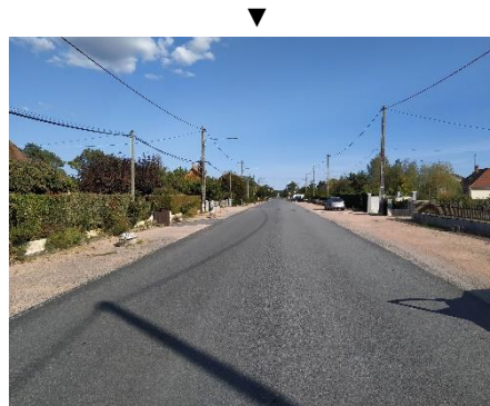
Entrée ouest de la RD915
