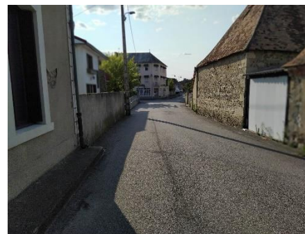
La rue d'Alcantera vers la RD997 n'est constituée que d'enrobé
