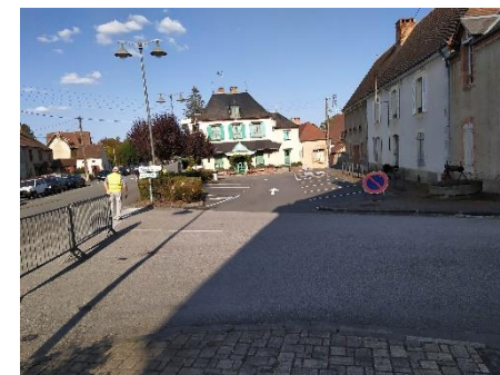
Le traitement de l'espace public revêt un caractère routier
