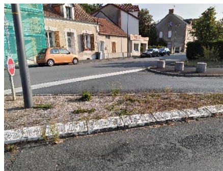
Les aménagements routiers dominent l'espace urbain
