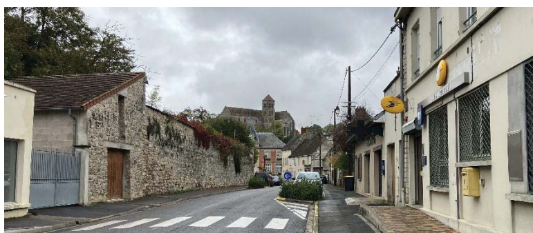
Figure 36 : Photographies du bourg ancien à Oulchy-le-Château
