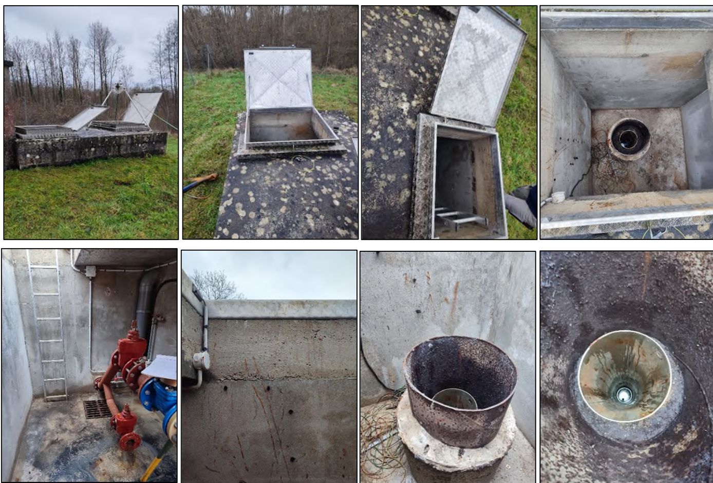
Figure 4 : Vues sur le génie civil de tête
