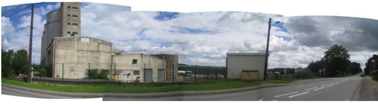
Les silos de Champagne céréales dits "de la Sucrierie" à l'entrée de la zone, le long de la R.D.966
