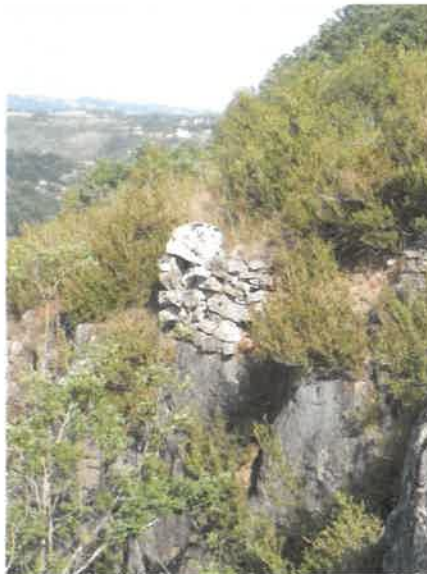
Figure 77 : Détail des éléments à purger sur la zone (SLa)
