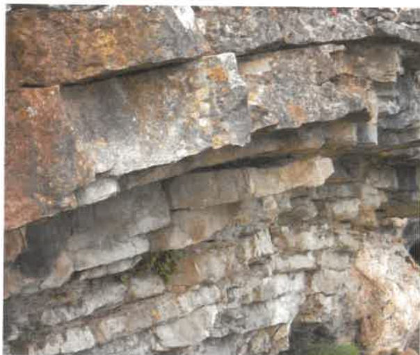
Figure 15 : Détail des éléments à purger A9 (Mai)
