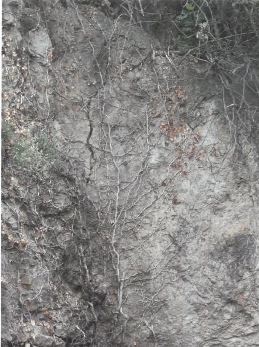
Figure 27 : détail fissure de libération de contrainte A16 (Mai)
