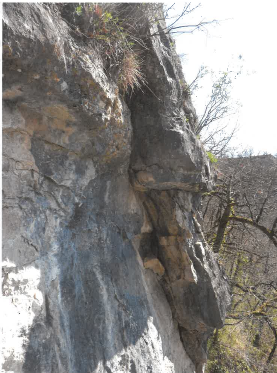
Figure 61 : Aléa 14 vue latérale gauche des deux écailles (Cim)
