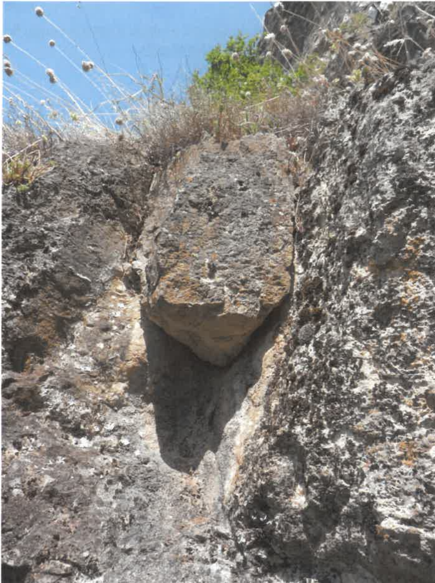
Figure 22 : Détail d'élément à purger secteur A13 (Mai)
