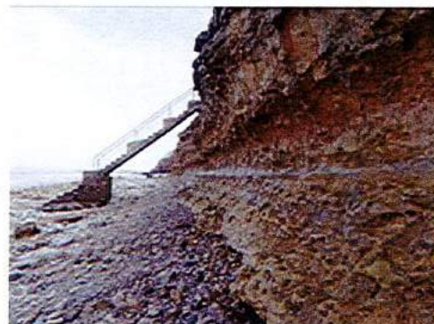
L'escalier de Grand Bec - commune de Villerville
