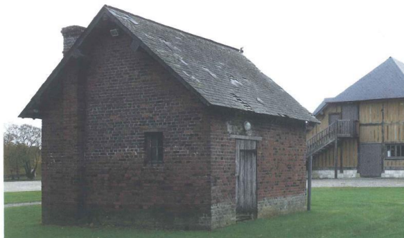
Bâtiment B : bouillerie
