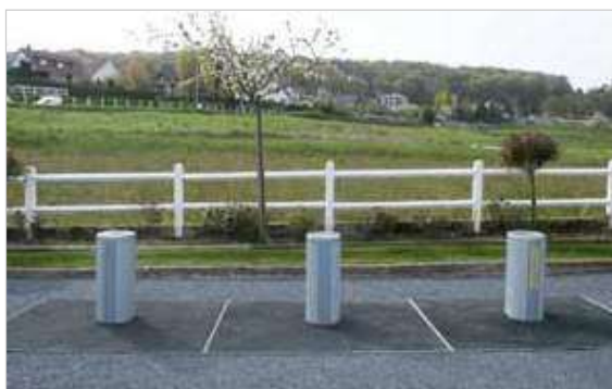
Exemple de PAV avec des conteneurs enterrés sur le territoire de la Communauté de Communes.
