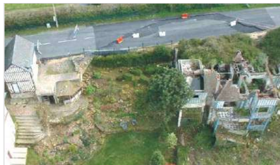
Glissement de terrain à Villerville (source : DREAL Basse Normandie)
