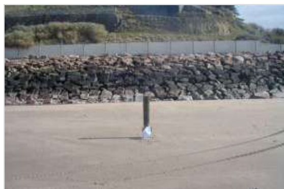
Repère de la station 32 à Villerville le 25/03/2009 (source : CG 14)
