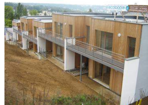
Exemple d'isolation extérieure réalisée avec un bardage bois.
