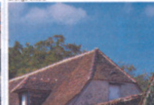
Couvertures en tuiles canal et plates
