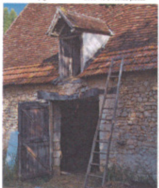
Lucarne à foin au-dessus de la porte de la grange
