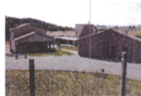
Equipement public, l'école de Fossemagne
