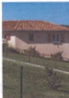
Intégration dans la pente
