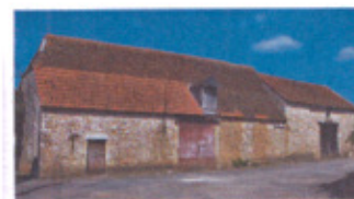
Granges étables en alignement, à rez-de-chaussée et à étage
