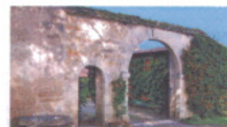
Mur et double porche en pierre
