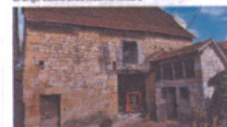
Grange étable à étage et abri à cochons
