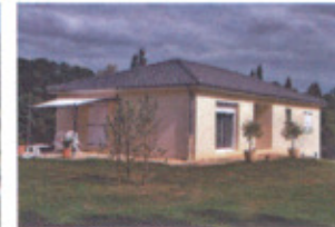
Toiture à faible pente couleur ardoise
