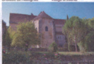
Toitures en tuiles plates et lauzes
