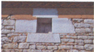
Appareillage quasi pierre sèche en jurassique, tendons en bois
