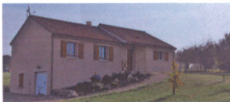
Construction sur terrain en pente
