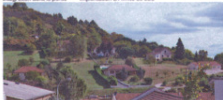
Constructions dans la pente, vision de loin
