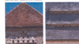
Fuyes dans pignon de grange
