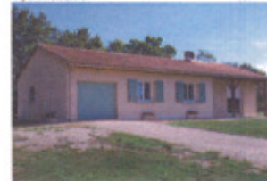
Toiture à faible pente
