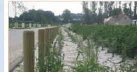
Une noue collectrice des eaux pluviales.
