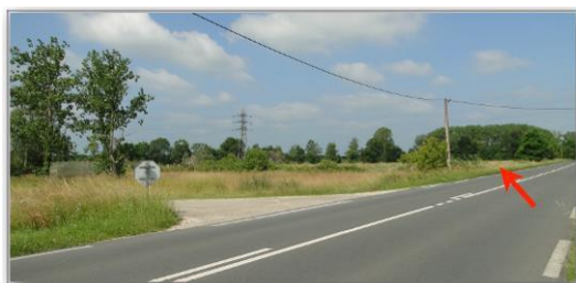
Entrée du projet depuis la RD 6089
