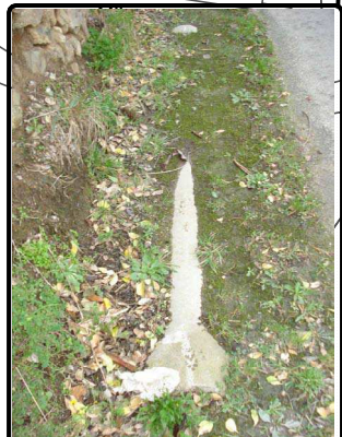
Le réseau pluvial est apparent sur environ 300 ml.
