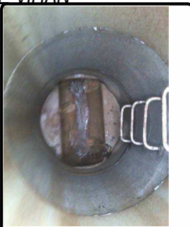
Réseau pluvial : un drain est conecnté au réseau (drainage de la parcelle agricole à l'ouest)
