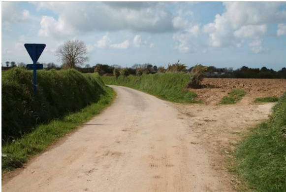
Figure 13 : Exutoire vue aval
