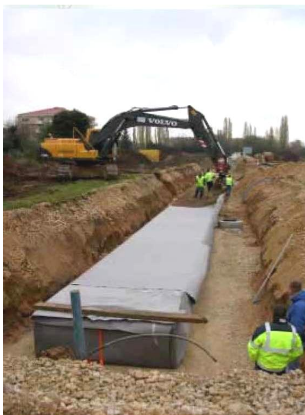
Fermeture de la structure
