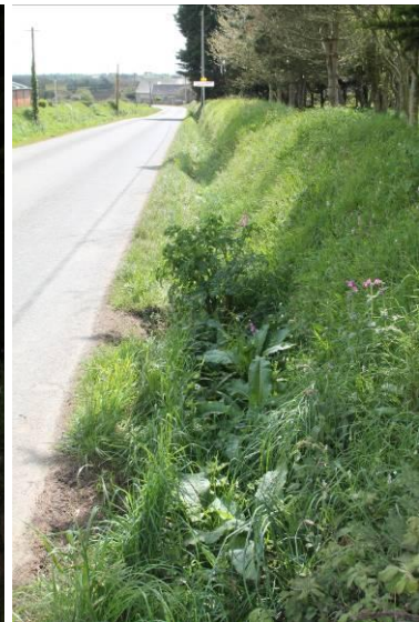
Figure 16 : Fossé à droite de la chaussée.
