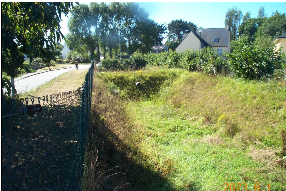
Figure 5 : Bassin tampon du « Hameau des Sturnes ».
