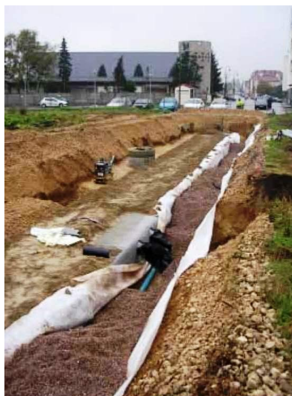
Remblaiement de la structure
