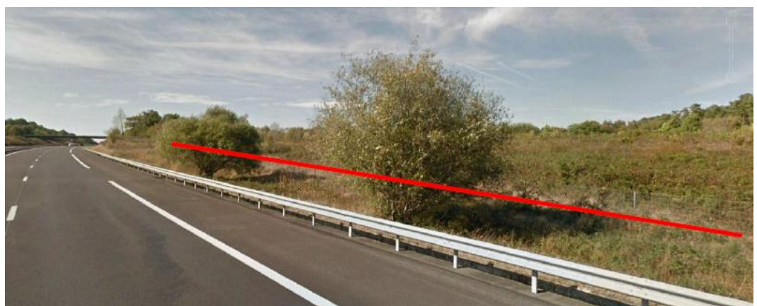
Vues depuis l'autoroute A 89, au sud-ouest des terrains étudié
