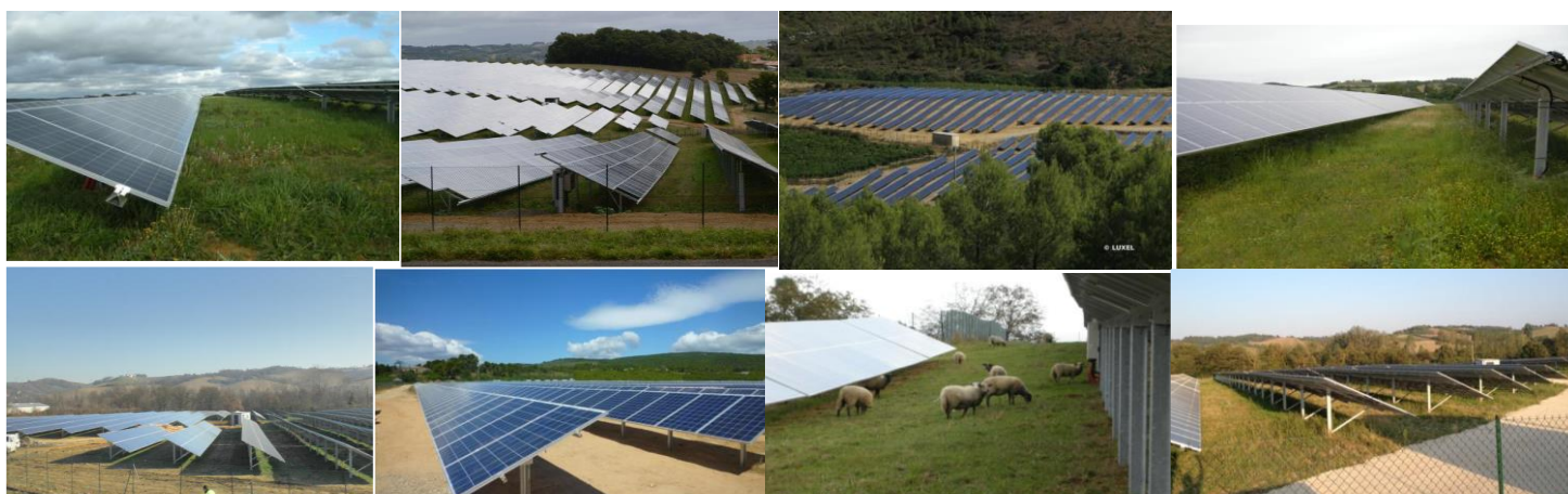
Figure 4 : Exemple de parcs photovoltaïques ( étude d'impact )
