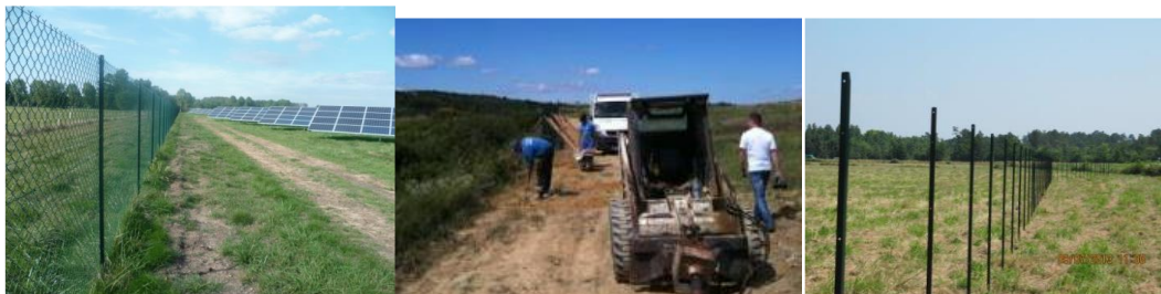
Figure 9 : Mise en place de la clôture (source étude d'impact)
