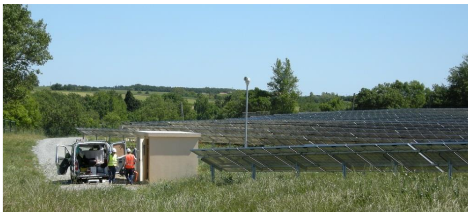
Figure 14 : Opération de maintenance ( source étude d'impact )
