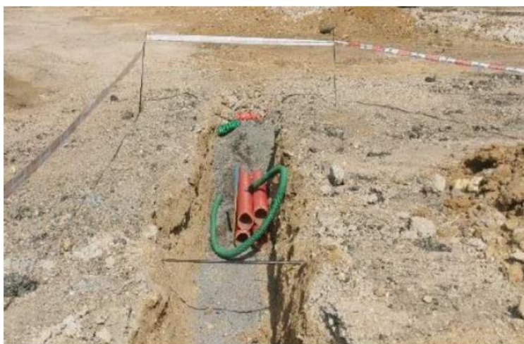
Photographie 51 : Exemple de fourreaux en tranchée (Source : SOG Solar)
