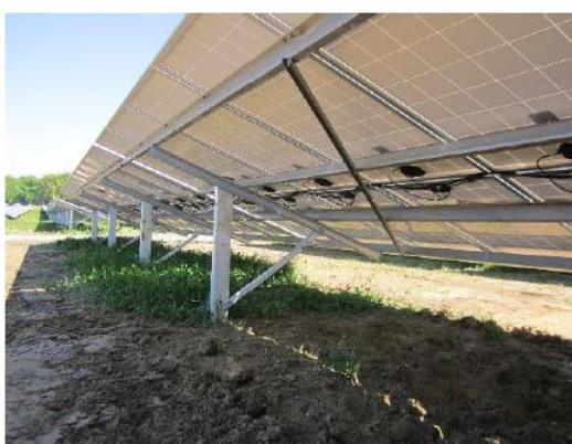
Figure 11 Exemple de structure monopieux favorisant l'activité agricole et l'entretien)
