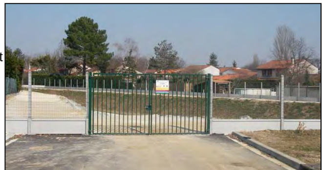
Implantation d'une clôture et d'un portail d'accès
