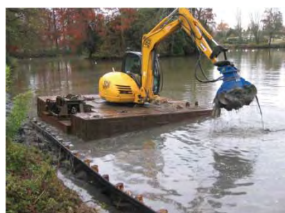
Curage du fond de bassin
