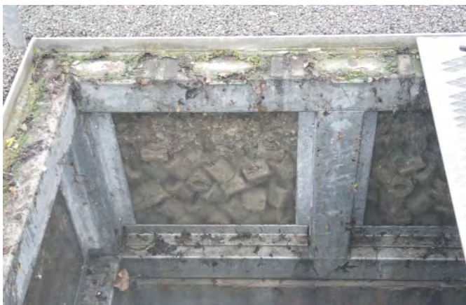
▲ Structure Réservoir (module béton)- Avenue de l'université à Talence
