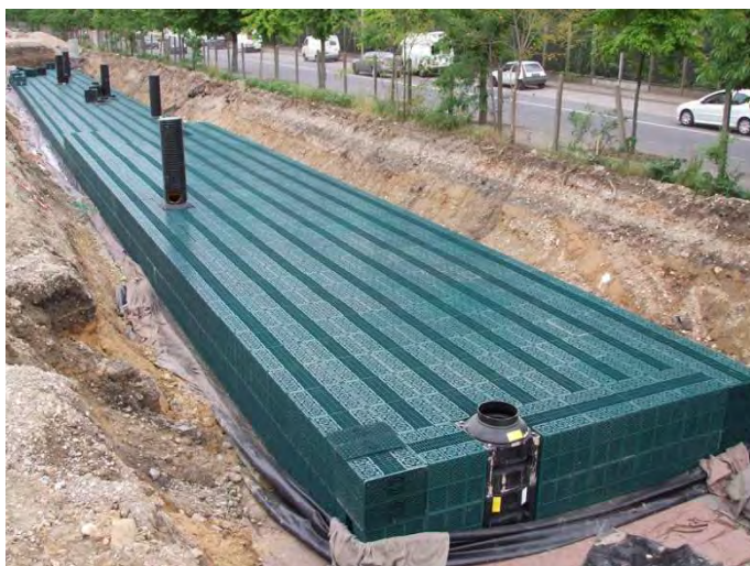
Bassin enterré à structure alvéolaire
