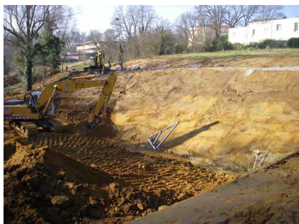
Travaux Terrassement / Remblais
