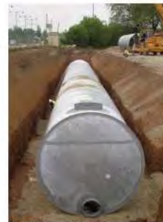
► Canalisations de stockage en acier (source : tubastar)
