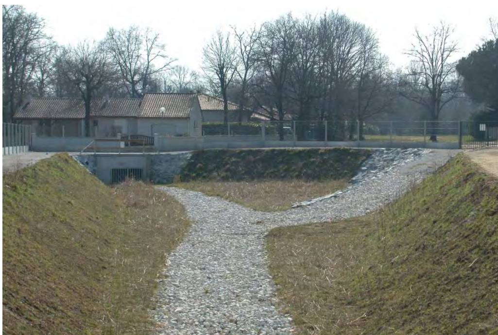
Bassin Lagorce Rue de Grattecap à Blanquefort
