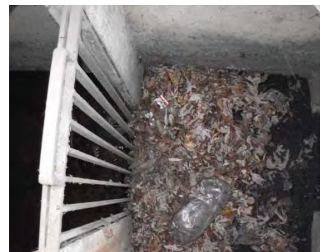
Ramassage régulier des flottants - Nettoyage des ouvrages Entrée/Sorties
