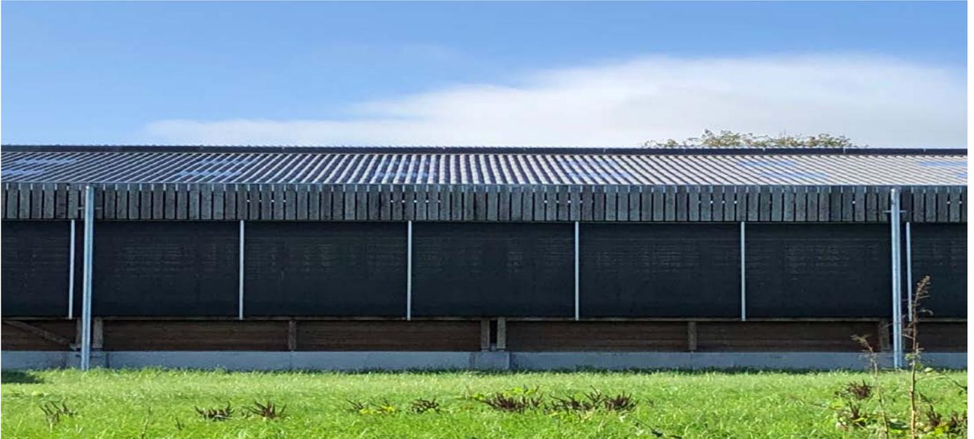
Par exemple, la façade d'un bâtiment très long peut être découpée grâce aux descentes d'eau pluviale qui viennent découper et encadrer des parties. Il faut bien entendu que ces descentes d'eau pluviales soient bien mesurées et dessinées de manière à devenir un élément architectural de qualité.
